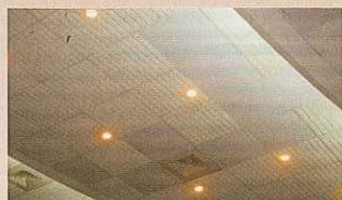
天花板換新、出風口強化固定
