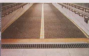
施作前▲無障礙坡道地面防滑整修工程▲施作後
