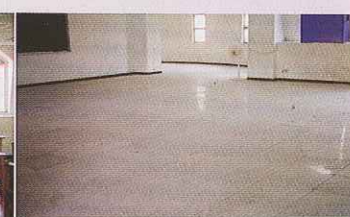
施作前▲四樓教室地坪新作磨石子地磚工程▲施作後
