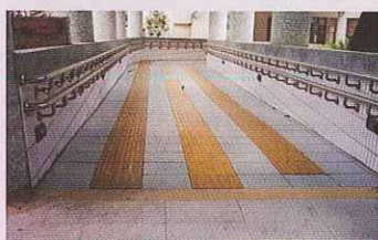
施作前▲無障礙坡道地面防滑整修工程▲施作後
